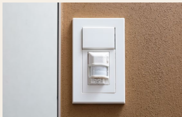
人の動きを感知して自動点灯する 人感センサー対応(玄関)
