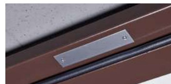
全住戸の玄関扉と窓に設置した 防犯マグネットセンサー ※FIX窓、面格子付窓を除く。
