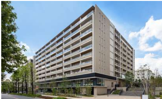
ドレッセWISEたまプラーザ / 2018年7月竣工
