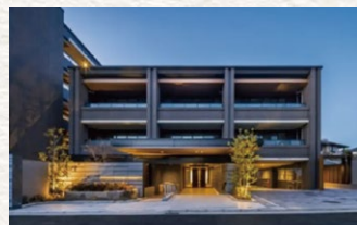
ドレッセ港北ニュータウン中川
